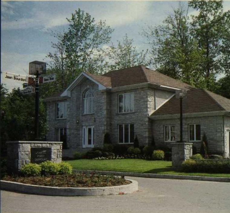
La maison abritant le bureau-chef...
