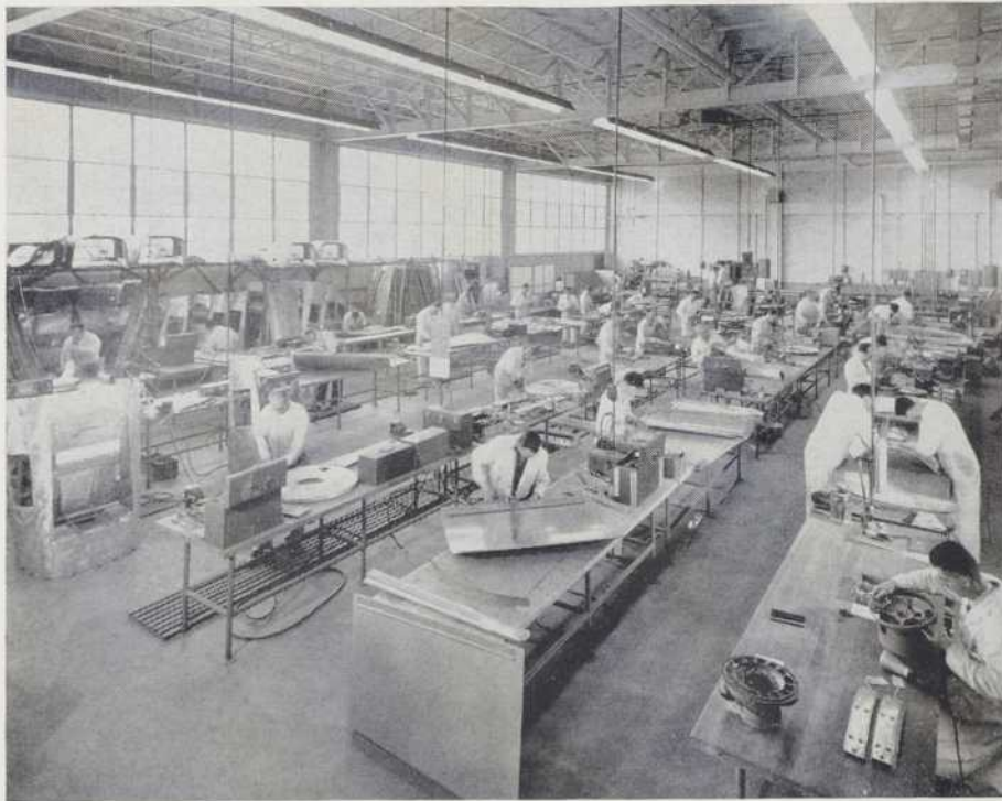
Autres vues de l'usine. La Bristol s'occupe principalement de vérifier, de mettre au point et de tester les moteurs d'avions qui ont fonctionné pendant un certain nombre d'heures. Le principe de la ligne d'assemblage est appliquée partout dans l'usine.
