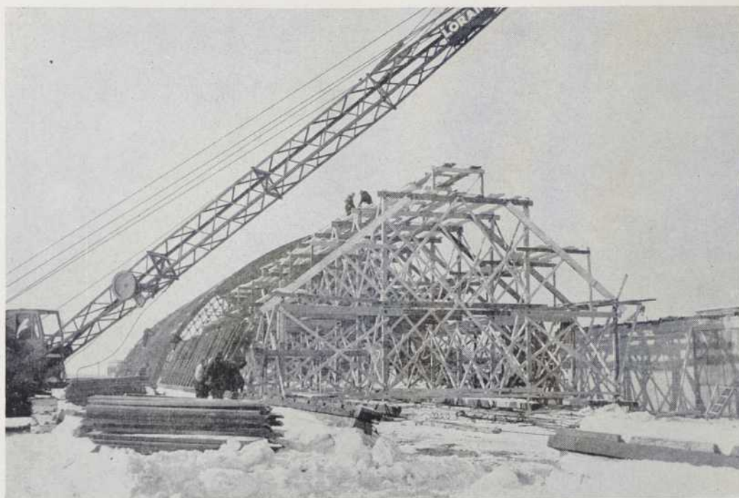
La charpente au cours d'érection. Ci-contre, coupe de la charpente et en bas, la charpente non revêtue. Les utilisations de cette méthode de construction sont nombreuses. On pourra en faire un entrepôt, une usine, un garage, mais aussi une salle de spectacle, un centre récréatif, un gymnase, un curling et même une église.
