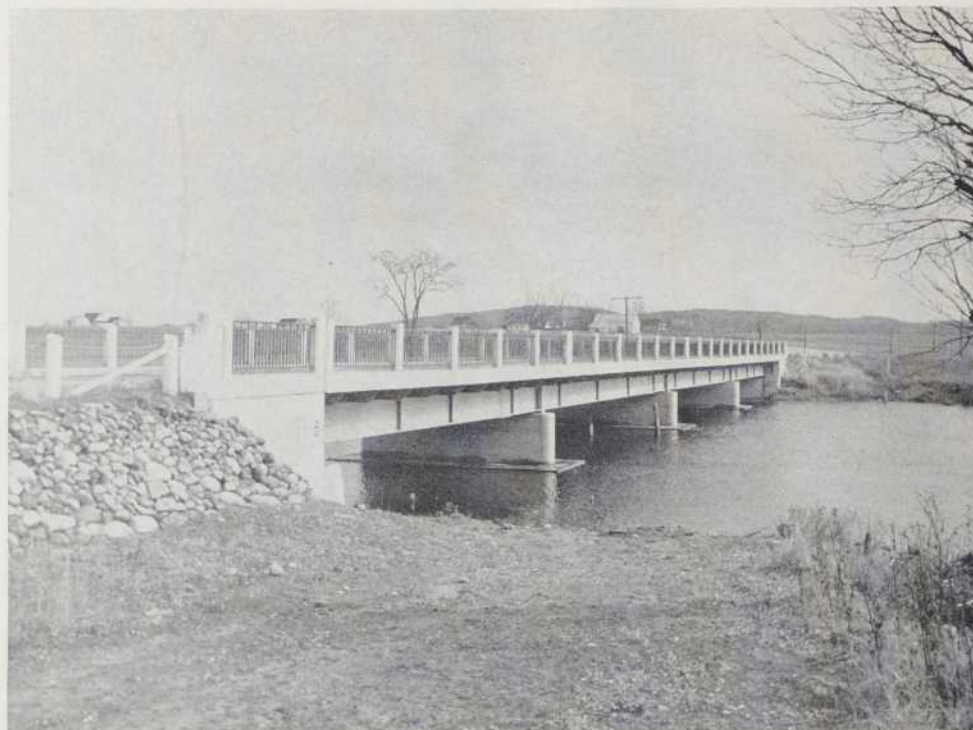
Pont Beauparlant, sur la rivière Maskinongé, entre St-Charles de Mandeville et St-Gabriel de Brandon. Il s'agit d'un pont de 220' divisé en deux travées de 60' et deux travées de 50'. On remarque une superstructure métallique et une substruction en béton reposant sur des pilotis en acier de 65' de longueur. Superstructure de Camille Hébert, Ing. P.
