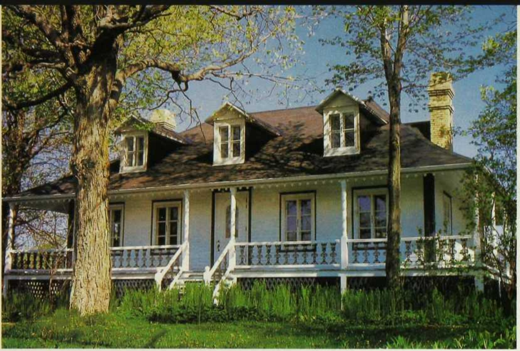
Cottage d'influence anglaise à un étage surmonté d'un toit à quatre versants bas, apparu au début du XIX e siècle.
