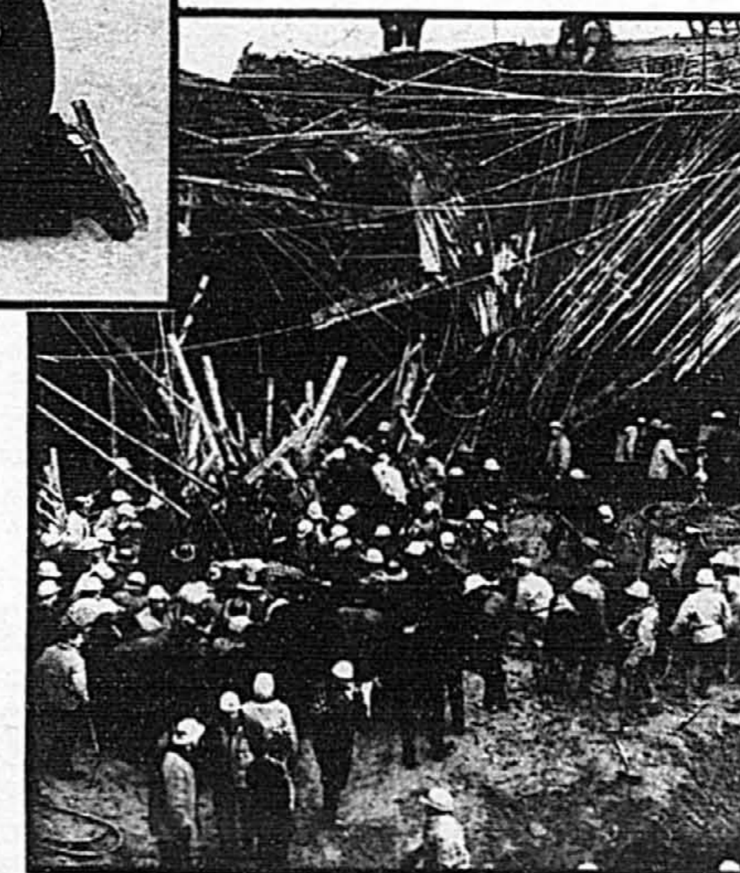
1965: Effondrement d'un viaduc sur l'autoroute transcanadienne à Montréal
