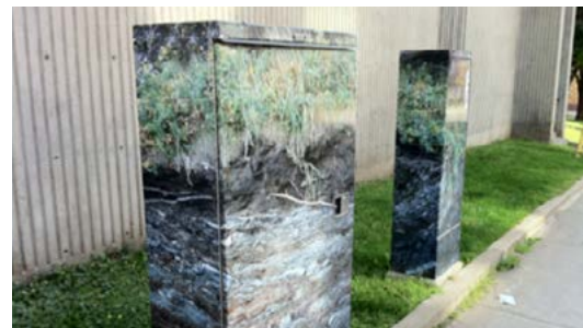
Figure 29 : Boîtes électriques peintes
