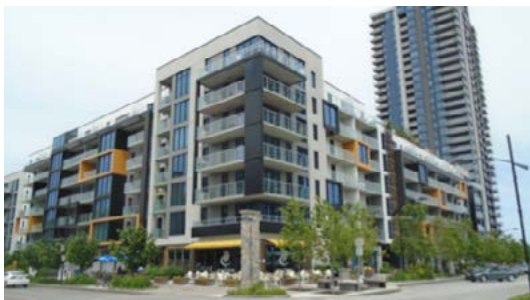
Figure 43 : Bâtiment présentant une mixité d'usages
