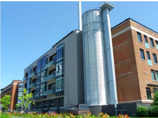
Figure 32 : Système de chauffage central à la biomasse
