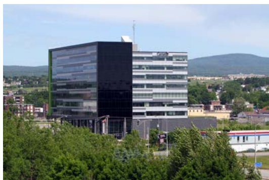
Figure 48 : Premier édifice construit à Pointe-D'Estimauville
