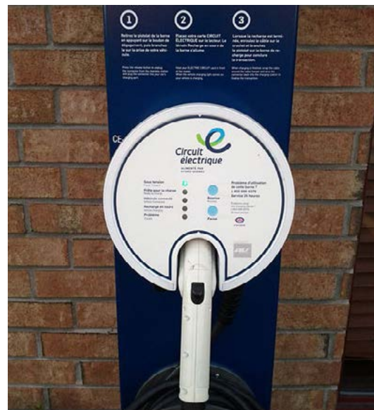
Figure 5 : Borne de recharge du Circuit électrique
