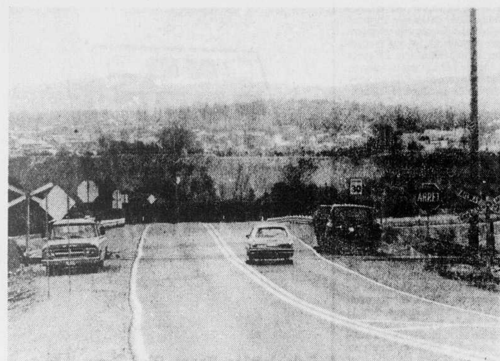
Quelques employés de Quebec Central procédaient hier au début des travaux en vue de l'installation des feux de signalisation à la voie ferrée du boulevard Pie XI. (Photo La Tribune, par Jacques Dussault)
