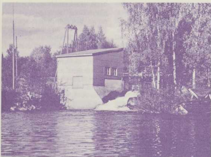
Une des technologies où les Finlandais s'estiment experts: les turbines électrogènes pour l'exploitation des petites rivières, de faible puissance. La turbine installée à cette station de Kanuskoski en 1958 a une puissance de 250 kW.
