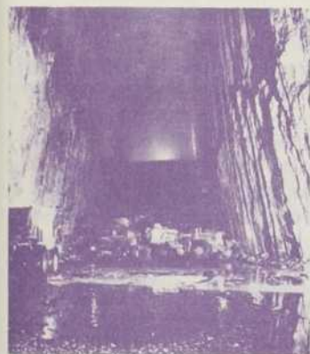
Les Finlandais ont développé une grande compétence dans la construction de cavités souterraines pour stocker le pétrole sur une très longue durée.
