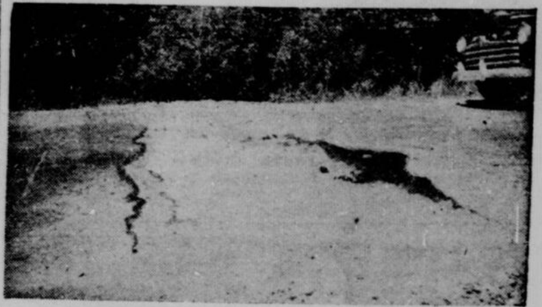
Photo prise par M. Emile Perreault, ami de la famille Langevin, montrant une crevasse de 4 pouces de profondeur et de 18 pouces de largeur, sur la route de St-Donat-Mascouche. C'est en cet endroit que M. Langevin perdit le contrôle de sa voiture et que sa petite fille Lise trouva la mort.
