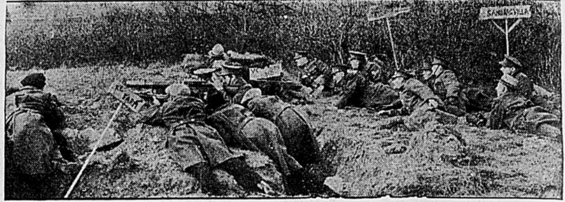
(Photo LPS) La tranchée est finie; les hommes s'y installent, prennent possession des mitrailleuses et fusils et guettent l'ennemi qui s'approche. A remarquer les affiches humoristiques qui se lisent "Villa des sacs de sable", "Chemin de la V.C. (Victoria Cross)", ainsi que l'identification "Régiment de Maisonneuve."
