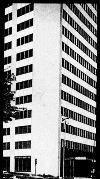
Le Centre Professionnel à Montréal Le "tout électrique" permet d'accroître de cinq pour cent l'aire totale de location
