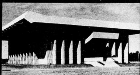
Les Caisses populaires Desjardins à Trois-Rivières Le "tout électrique" s'impose dans un immeuble moderne
