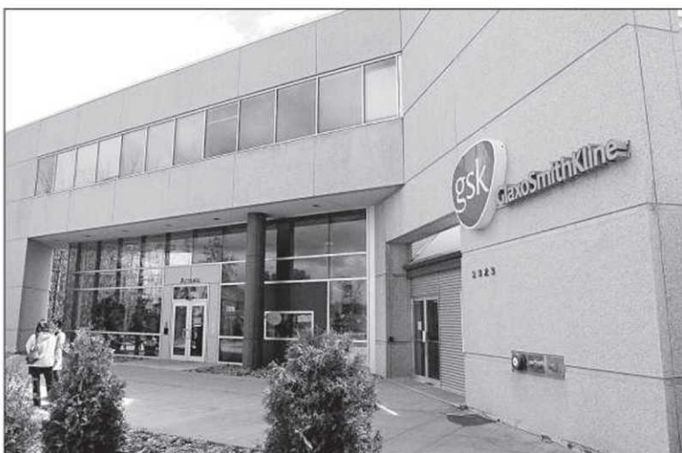
L'agrandissement du Centre de production de vaccins de GlaxoSmithKline (GSK) du Parc technologique de Québec construit au coût de 200 millions $ s'est vu décerner un prix pour la qualité unique de ses installations.
