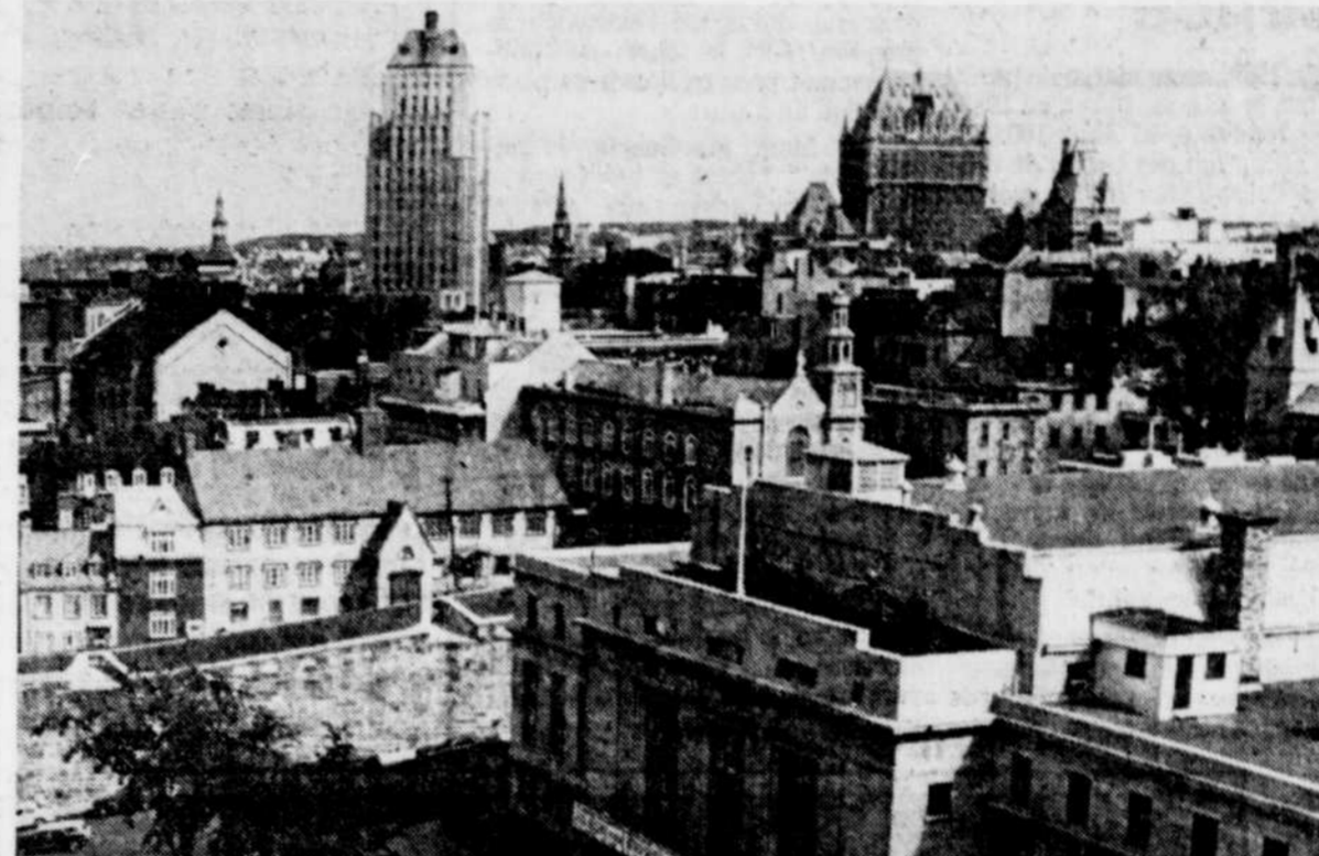
L'édifice Price et le Château Frontenac, deux édifices représentatifs de la ville de Québec.
