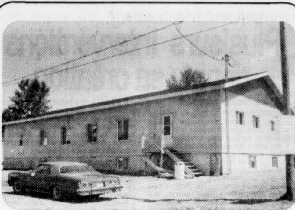
Les travaux de construction du nouveau centre communautaire de Saint-Tite ne sont pas encore terminés, mais il a déjà fière allure, comme on peut le voir sur cette photo.
