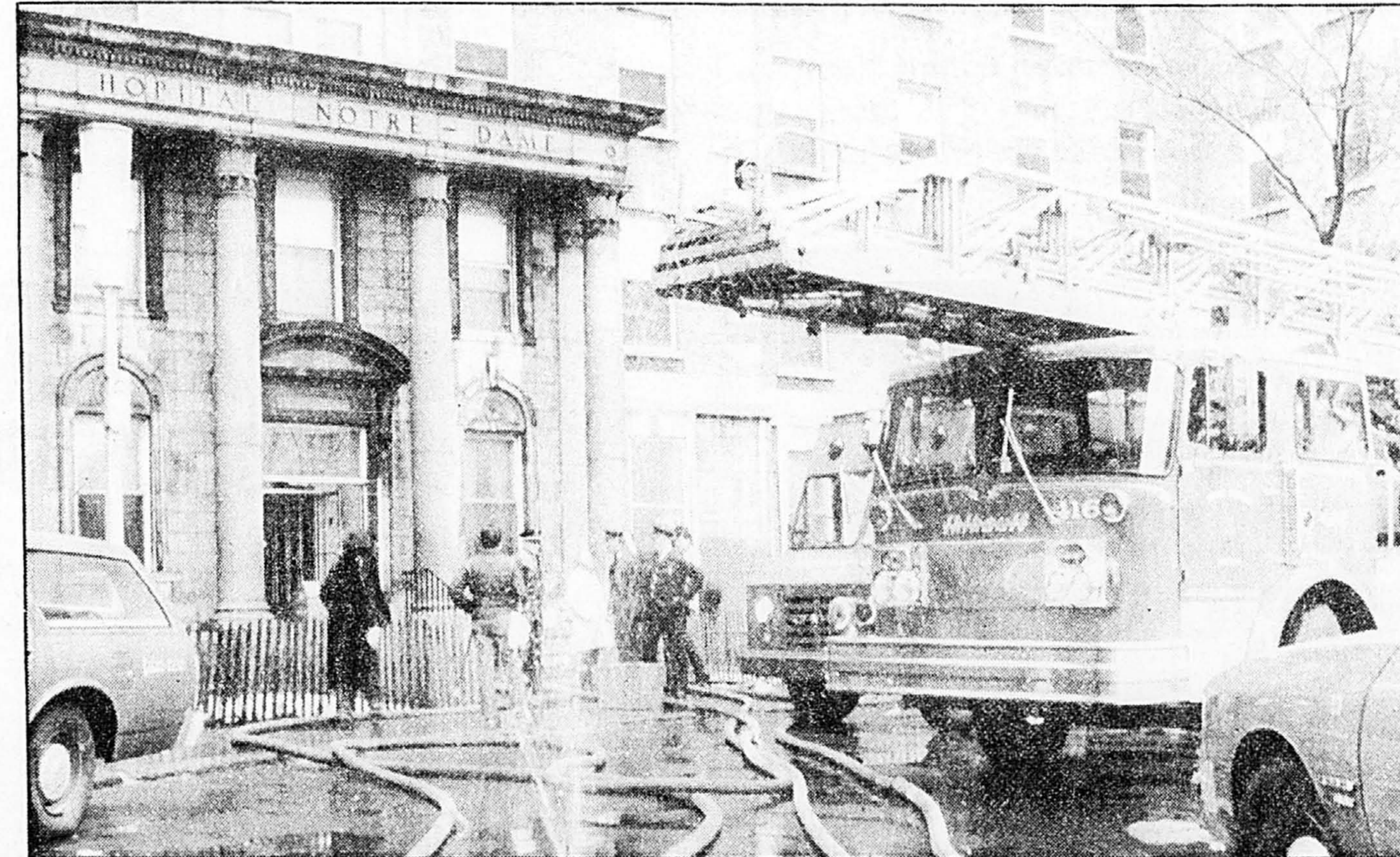
L'épaisse fumée se dégageant du sous-sol sans fenêtres a considérablement gêné le travail des pompiers. photo René Picard, LA PRESSE
