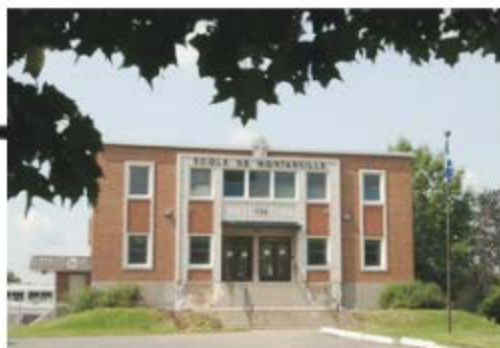
École Montarville vue de la rue Montarville
