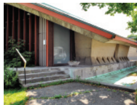
« ... deux grandes pentes de faible inclinaison ne s'appuient chacune que sur un pilier massif, à leur base. »
