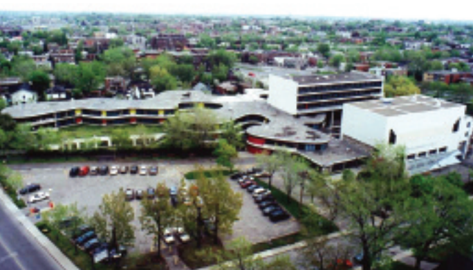
Complexe Marie-Clarac. Au premier plan, l'hôpital Marie-Clarac et ses formes organiques recouvertes de panneaux d'acier aux couleurs primaires.
