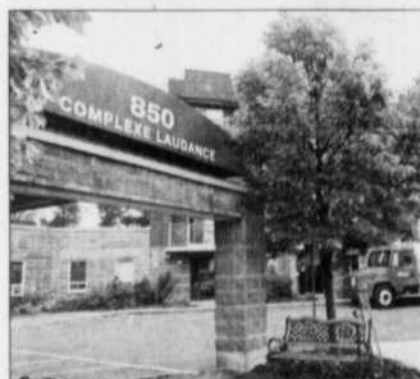
La panne n'aurait pu tomber à un pire moment, selon le porte-parole du propriétaire. «C'était en plein durant les vacances de la construction et on n'a pas pu avoir de contracteur avant le 2 août, dit Paul Moon. L'entrepreneur nous a dit à ce moment-là que ça prendrait au moins 12 jours de plus.»
