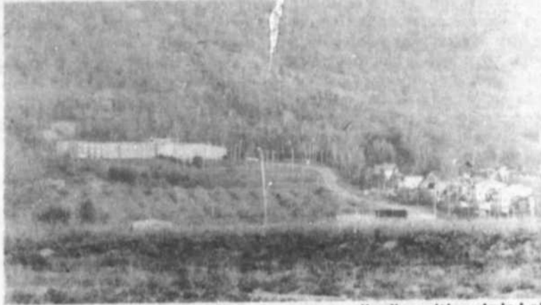
Mont-Saint-Hilaire a eu recours à une nouvelle disposition de la Loi sur l'Aménagement et l'Urbanisme du Québec pour s'assurer du parfait contrôle du développement de son futur centre-ville.
