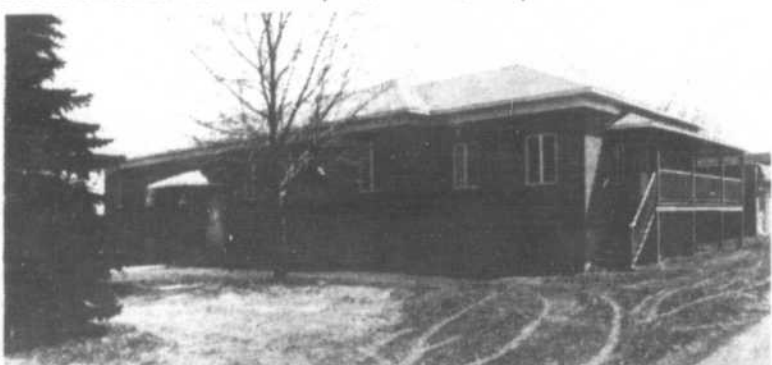
La construction de la résidence a débuté l'automne dernier. Les résidents sont arrivés le 1er mai. C'est grâce à la participation de nombreux bénévoles que le projet a pu être mené à terme.
