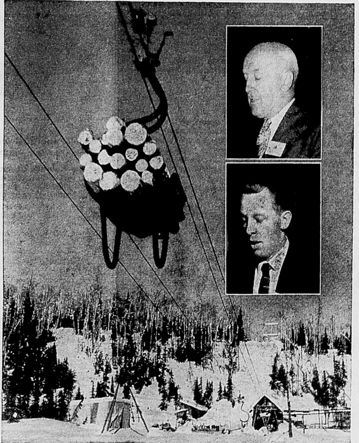
La Québec North Shore Paper Company se sert d'un transporteur aérien pour acheminer le bois à pàte du Québec au-dessus d'un terrain accidenté à Baie Comeau et Franquelin. Pour son exposé de cette méthode économique d'exploitation forestière, Rudy Vit, ingénieur du transporteur aérien de Baie Comeau, s'est vu décerner un prix lors de la récente assemblée annuelle de la section des opérations forestières de l'Association canadienne des pâtes et papiers. M. H. A. Sewell, à droite ci-dessus, vice-président préposé aux opérations forestières de la Québec North Shore Paper Co., a été réélu président de la section des opérations forestières de l'Association.
