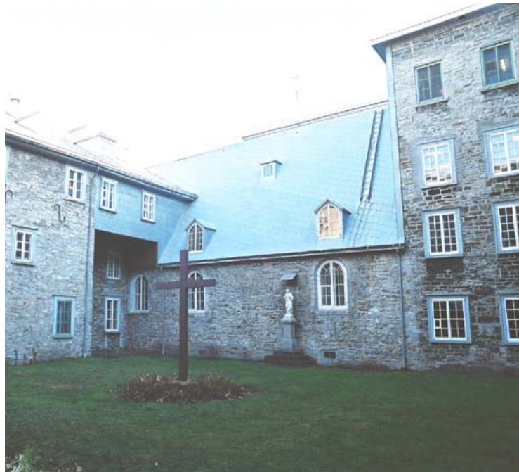
Fig. 4 Façade latérale nord de l'église. AAMHGQ, 81-21.
