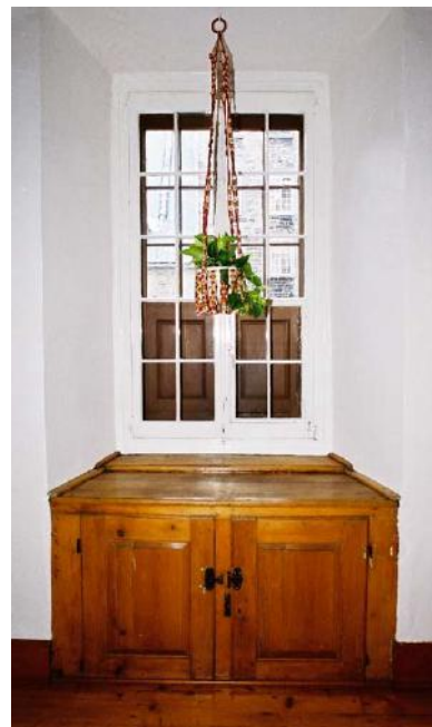
Fig. 140 Parmi les plus anciens éléments menuisés de l'aile de l'Apothicaire sont les « coffres-morts », armoires intégrées à la base des fenêtres. AAMHGQ, 91-21.
