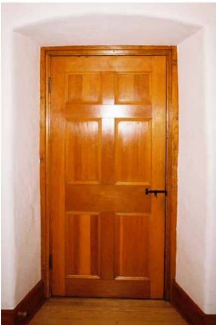
Fig. 157 Porte à six caissons (milieu du 19 e siècle) dans l'aile de l'Apothicaire. AAMHGQ, 91-19.
