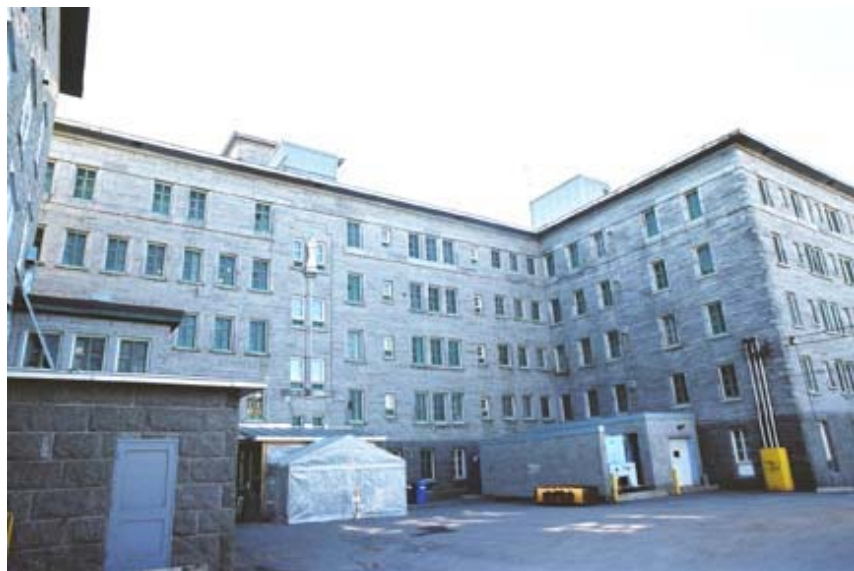
Fig. 49 Façade nord de l'aile Saint- Joseph. AAMHGQ, 79-19.
