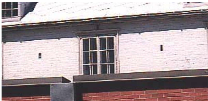
Fig. 79 Trois petites niches, dont une peu visible au-dessus de la fenêtre, intégrées dans la maçonnerie de la façade de l'ancienne buanderie (1856). Photo: Paul Trépanier, 2002.
