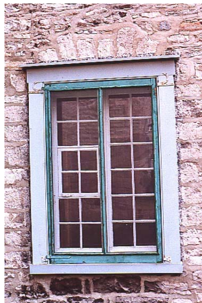
Fig. 102 Fenêtre à la façade ouest du bâtiment des Récollets. On peut distinguer sous l'encadrement de bois la forme arquée du linteau. Photo : Paul Trépanier, 2001.
