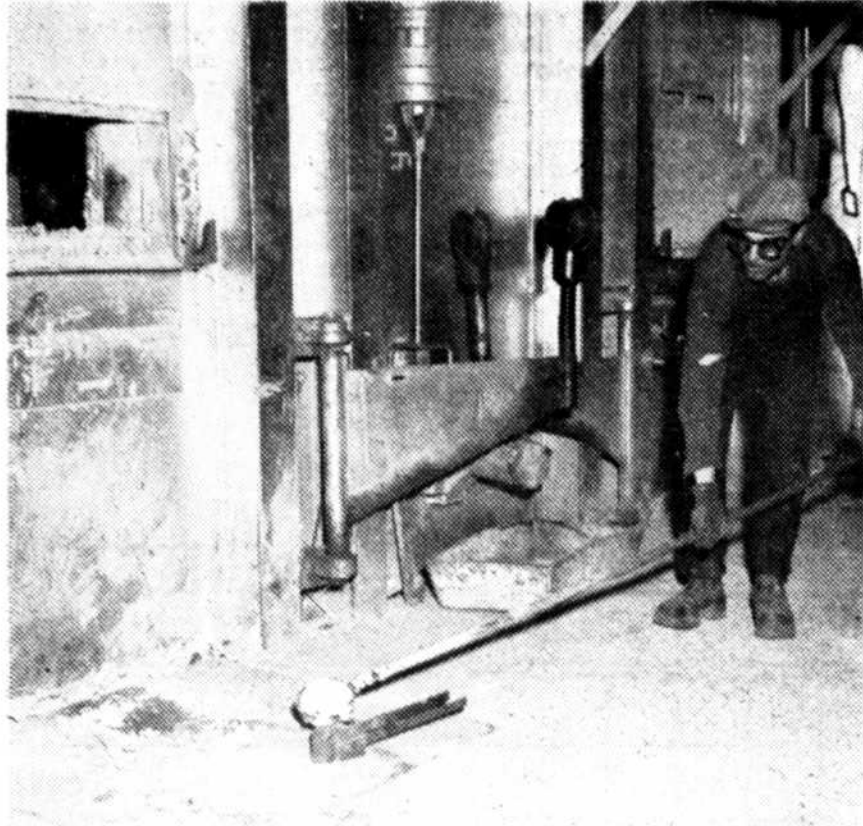
NOUS VOYONS ICI le préposé à la fournaie, prendre un échantillon à même le métal en fusion, et le couler dans un moule afin d'en faire des électrodes pour analyse.
