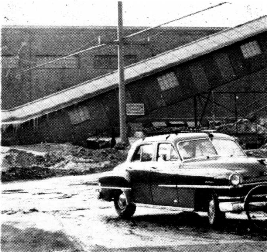
LE CYLINDRE CONTENANT L'ECHANTILLON file dans le tube, en direction du laboratoire à une vitesse de 20 milles à l'heure environ.
