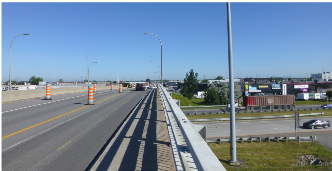
Photo 4-12 : Vue vers le nord depuis le boulevard Le Corbusier à la hauteur du pont d'étagement au-dessus de l'autoroute 440
