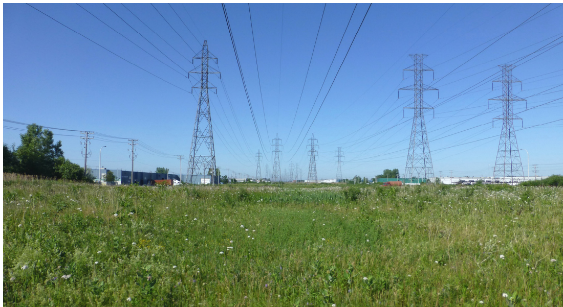
Photo 4-23 : Vue vers l'ouest du corridor vert à la hauteur de la propriété d'Hydro-Québec
