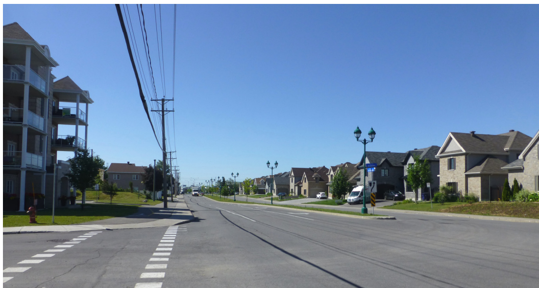
Photo 4-14 : Vue de la portion nord du boulevard Le Corbusier à l'angle de la rue des Grèbes
