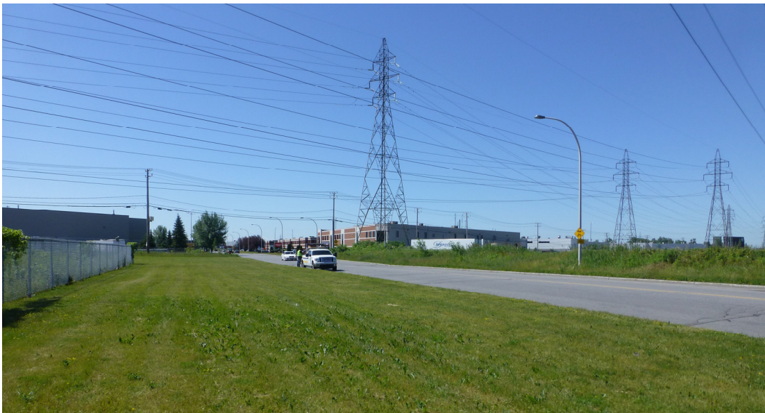
Photo 4-16 : Vue vers le sud du couloir de lignes de transport d'énergie depuis le boulevard des Rossignols
