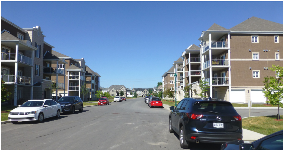
Photo 4-20 : Vue vers l'ouest depuis la rue des Grèbes – Résidences multifamiliales de quatre étages
