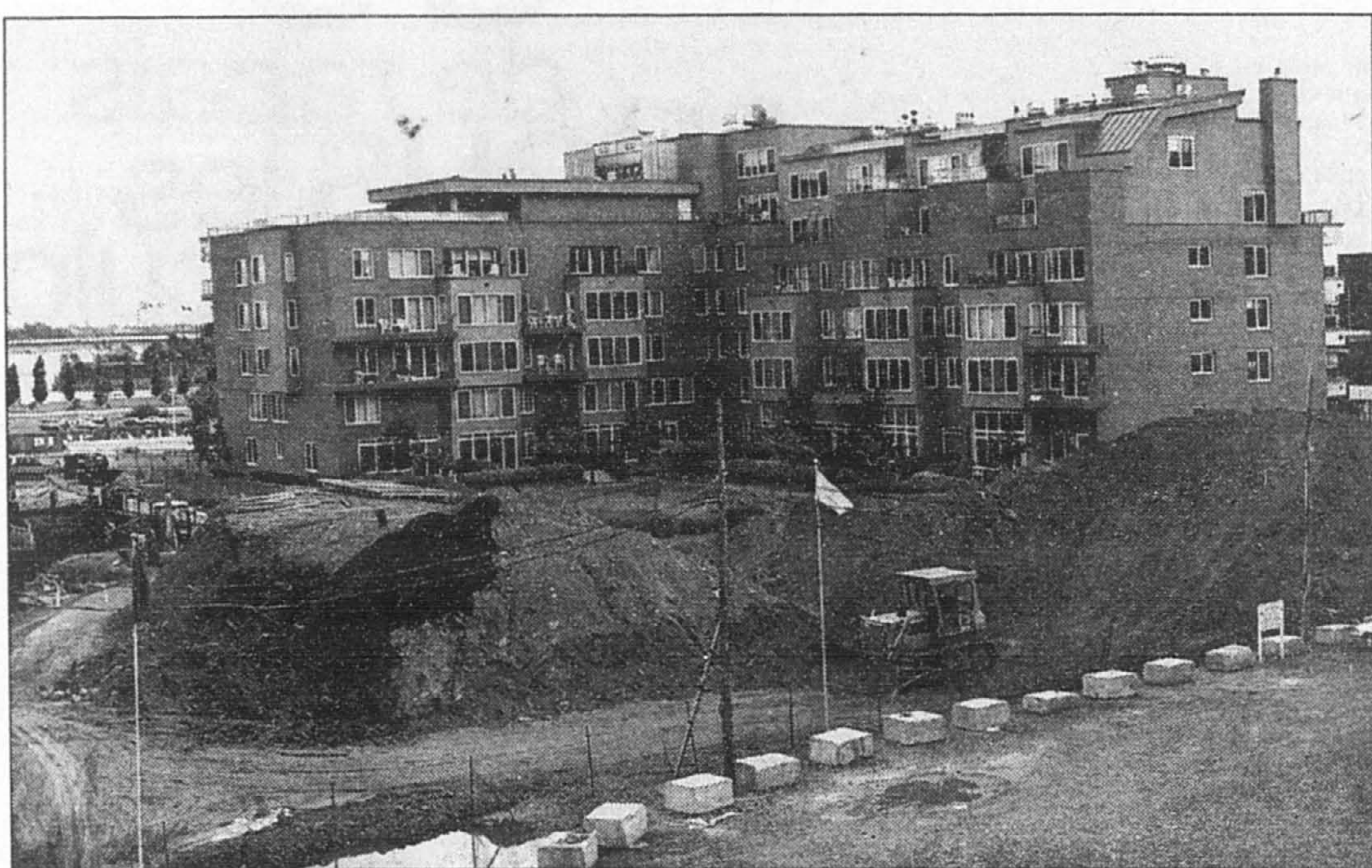
Une montagne de terre a été empilée derrière l'École du cirque pendant l'excavation des fondations du nouveau complexe résidentiel.
