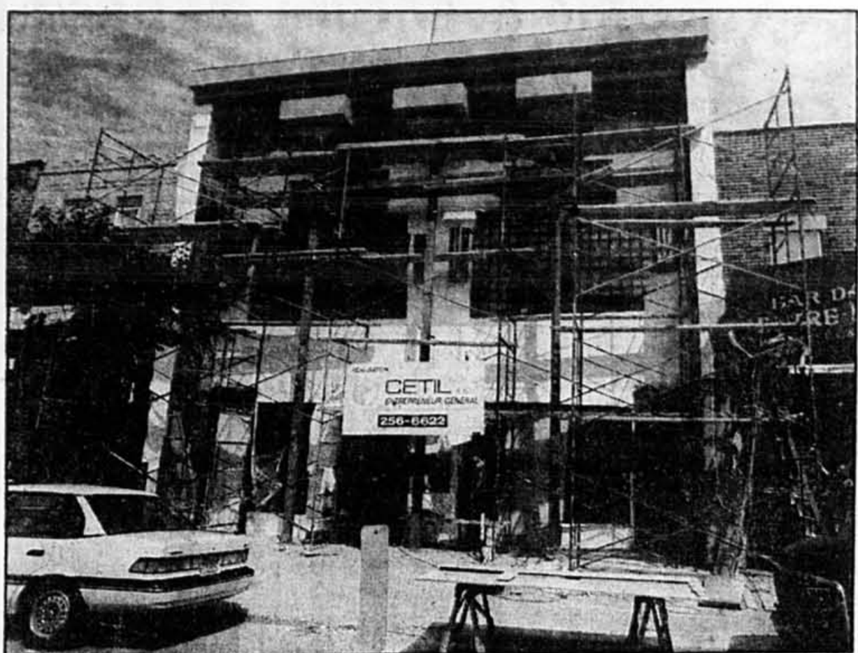
Les travaux vont bon train à l'édifice qui abritera La Licorne, rue Papineau.
