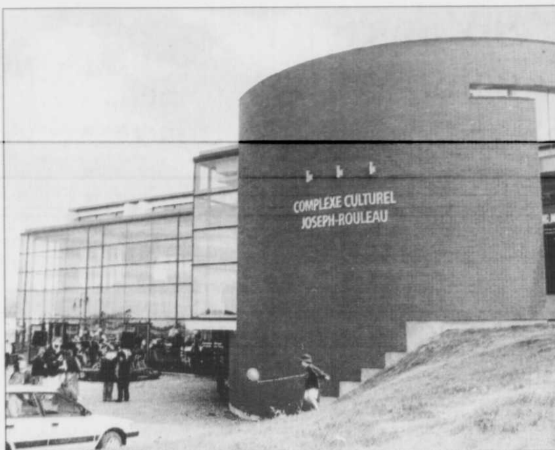
Conçu par Anne Carrier, Robert Boily et Jacques White, le Complexe Joseph-Rouleau relie la rue Principale et promenade des Capitaines qui donne sur la rive Matane.
