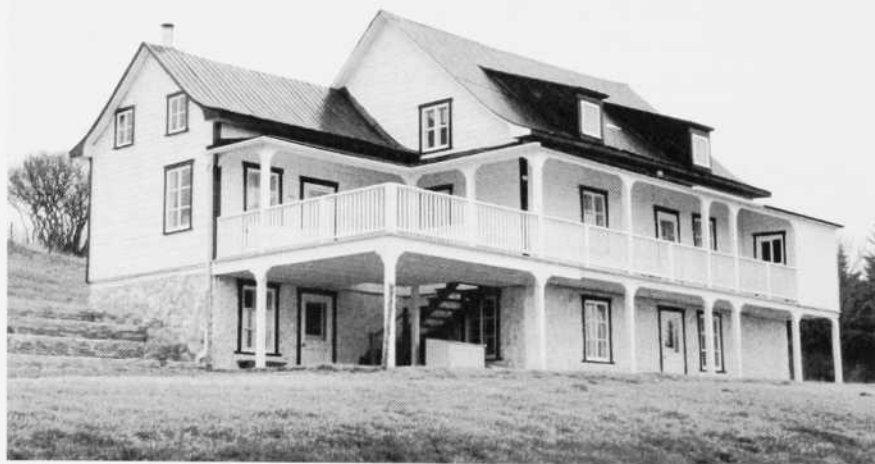
Ancienne maison d'Euclide Gauthier à Saint-Irénée (rang Terrebonne). Cette maison a fait l'objet d'une rénovation. (Photo Normand Perron)
