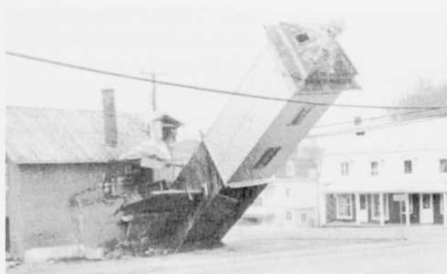
L'ancien poste à incendie en train de s'effondrer. (Municipalité de Ville Baie-Saint-Paul)
