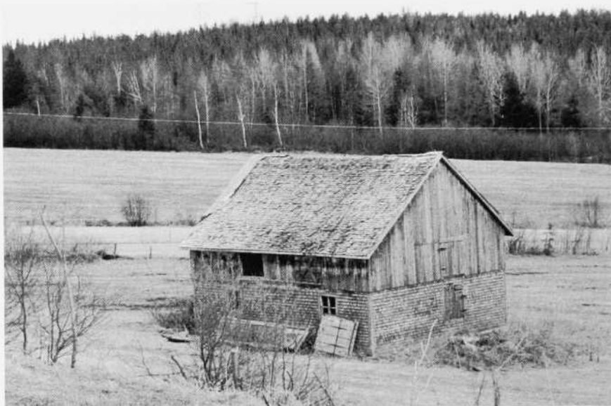
Bâtiment agricole abandonné dans un rang de Saint- Hilarion. (Photo Normand Perron)
