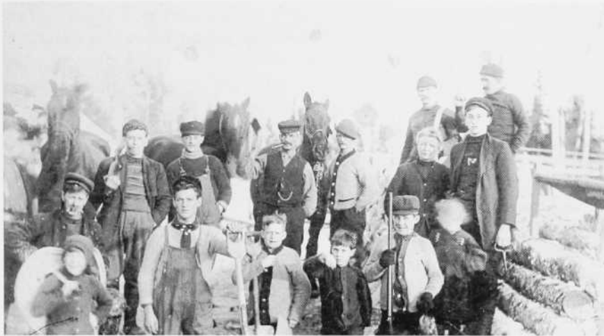
Lors de la construction d'un barrage pour la drave sur la rivière Noire à Saint-Siméon vers 1910.
