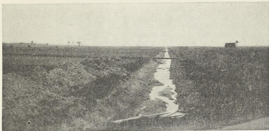
Après le passage de la pelle mécanique.
