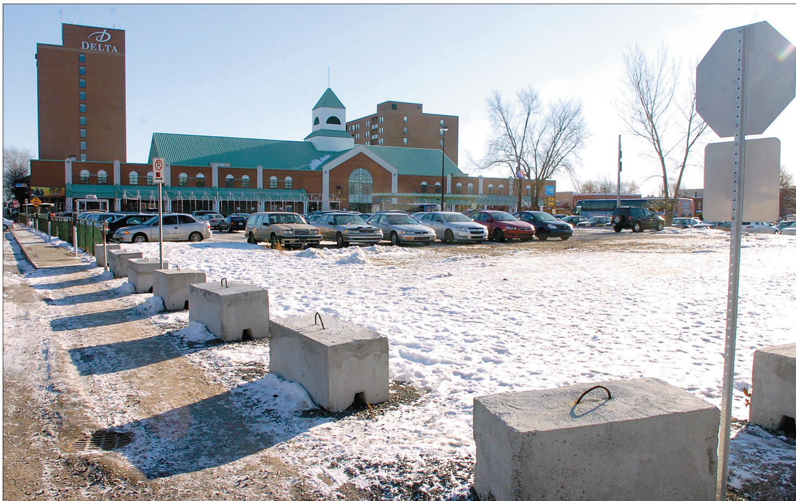
Les travaux de près d'un million de dollars seront complétés d'ici l'automne 2009 à l'angle des rues Saint-Georges et Champlain.
