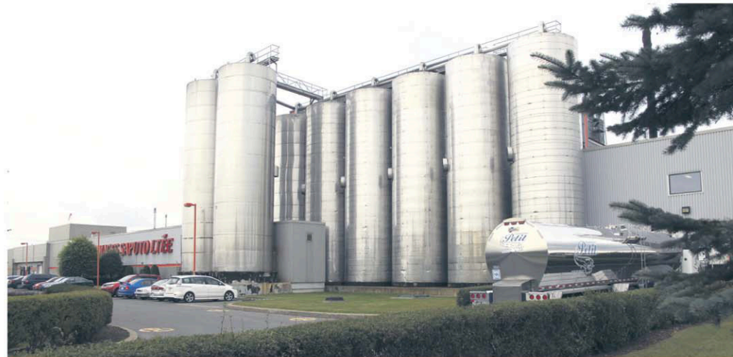
La Fromagerie Saputo possède une usine à la fine pointe de la technologie qui permet de traiter un dérivé du lait servant à la production de fromage.
