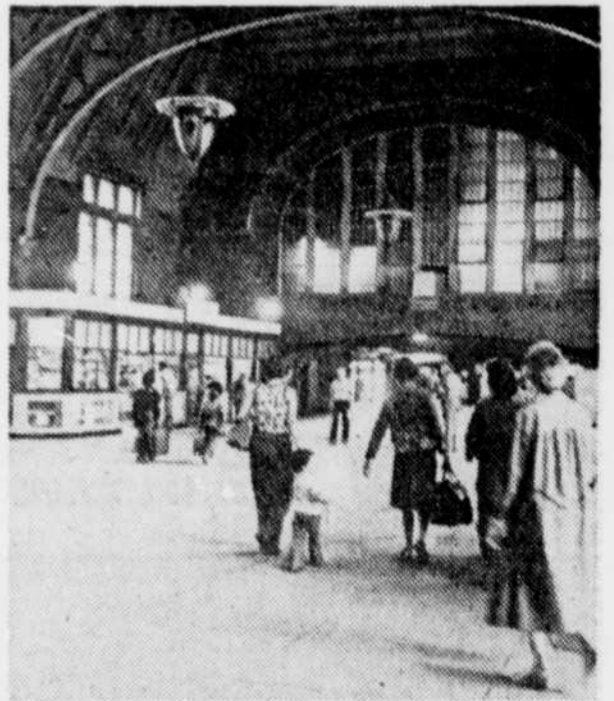
La gare du palais était à cette époque “l'entrée de Québec”.
