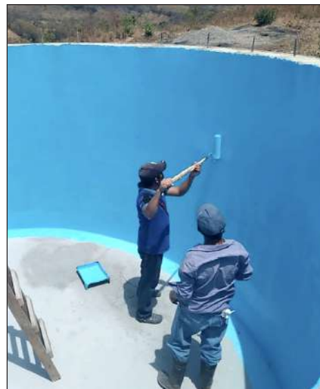
L'une des différentes citernes construites grâce au financement de Jumelage Saint-Félix.
