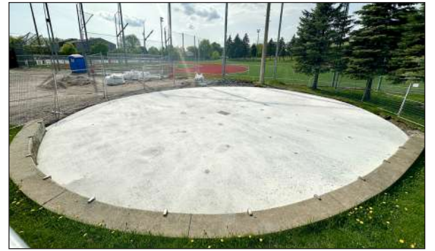
Le secteur des jeux d'eau actuellement en construction.
