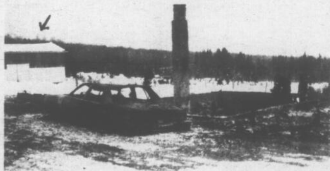
Derrière les ruines fumantes de la résidence des Roy, à Woburn, on aperçoit une partie de la grange-atelier qui a brûlé la fin de semaine suivante, avec tout ce qu'elle contenait, chevaux et outils. Le bâtiment était au moins deux fois plus large que la partie illustrée sur notre photo.
