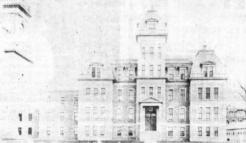
L'évêché avant l'ébouli
