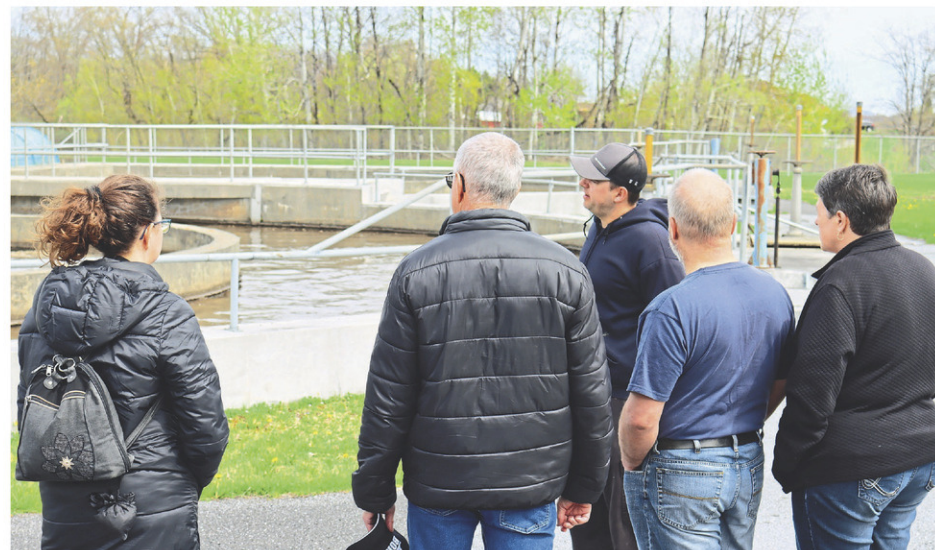
Les participants ont pu se familiariser avec la station d'épuration des eaux usées.
