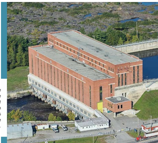
La vue transversale du bâtiment met bien en évidence les trois niveaux de la centrale.
