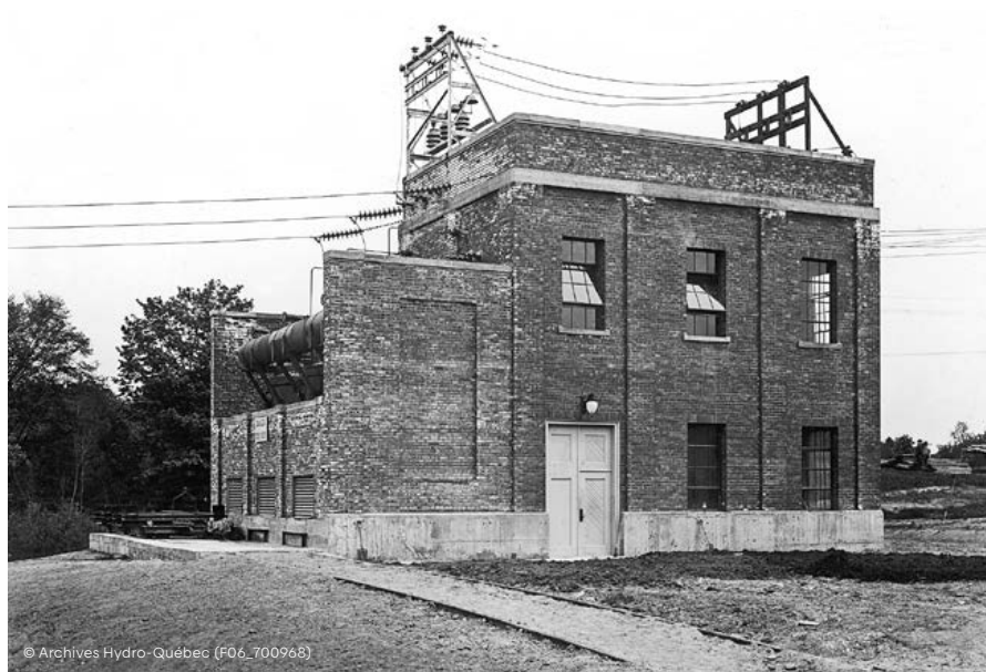
Ancien bâtiment de commande du poste blindé, érigé en 1928.
