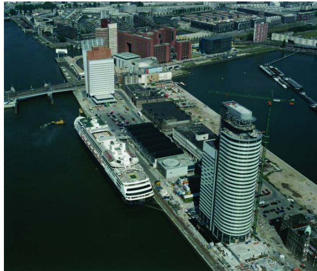
Vue aérienne du Wilhelmina Pier en construction.
