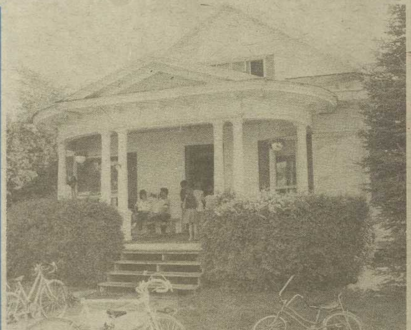
De nombreux curieux se sont massés sur la galerie de la maison dévastée.
