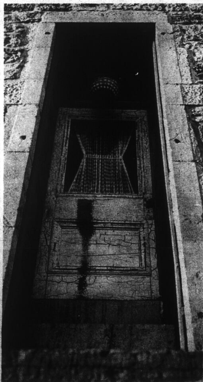
L'entrée principale, surélevée et très étroite avec mini-tambour encastré.
