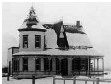
Maison Joseph-Lafontaine située au 199, 12 e rue.
