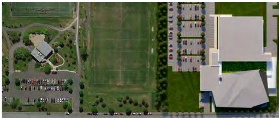
Le site du futur complexe sportif du parc Marie-Victorin. (Photo : courtoisie)
