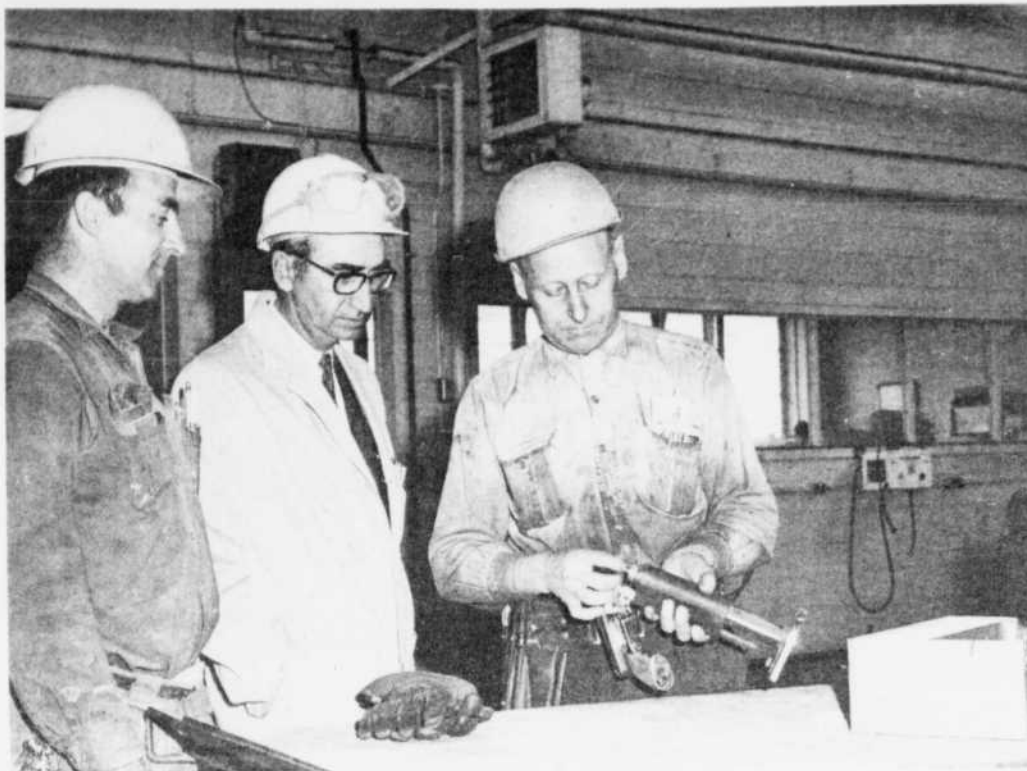
DEUX HOMMES D'EXPERIENCE. MM. Dollard Belley, à gauche, électricien à l'usine Alcan d'Isle-Maligne où il travaille depuis 16 ans, et Lucien Durocher, électricien, aussi à l'Alcan depuis 16 ans, utilisent ce fusil propulseur de boulons dans le cours de leur travail. M. Rosaire Tremblay, inspecteur de sécurité, fait sa tournée et reconnaît que ces employés, comme plusieurs autres dans la mécanique, chez les installateurs de tuyauterie et ailleurs, observent les mesures de sécurité recommandées.
