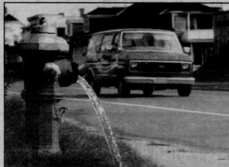
Un nouveau puits entrera en opération cet automne à Saint-Paul, doublant l'approvisionnement en eau de la ville.
