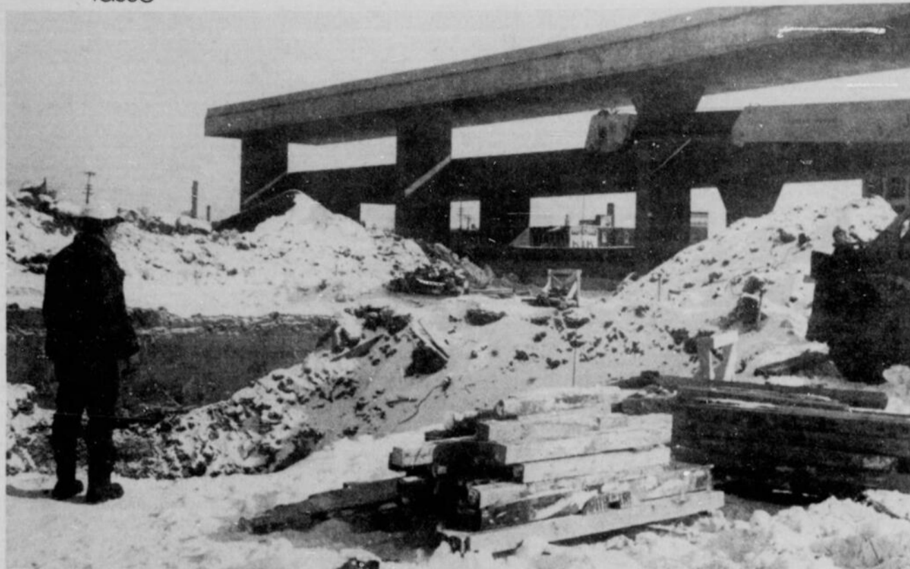
Les travaux sont déjà commencés à l'ouest malgré les protestations des citoyens.
