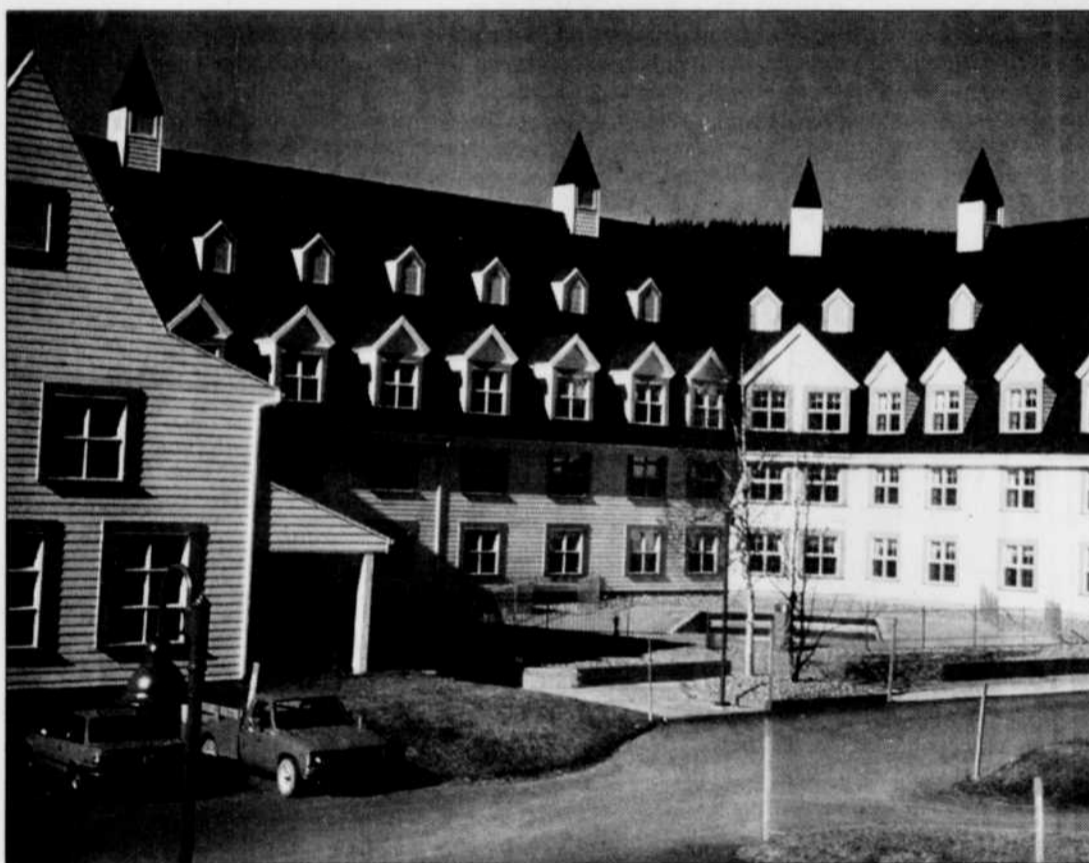
Pas moins de 40 chambres seront ajoutées au Gîte du Mont-Albert.
