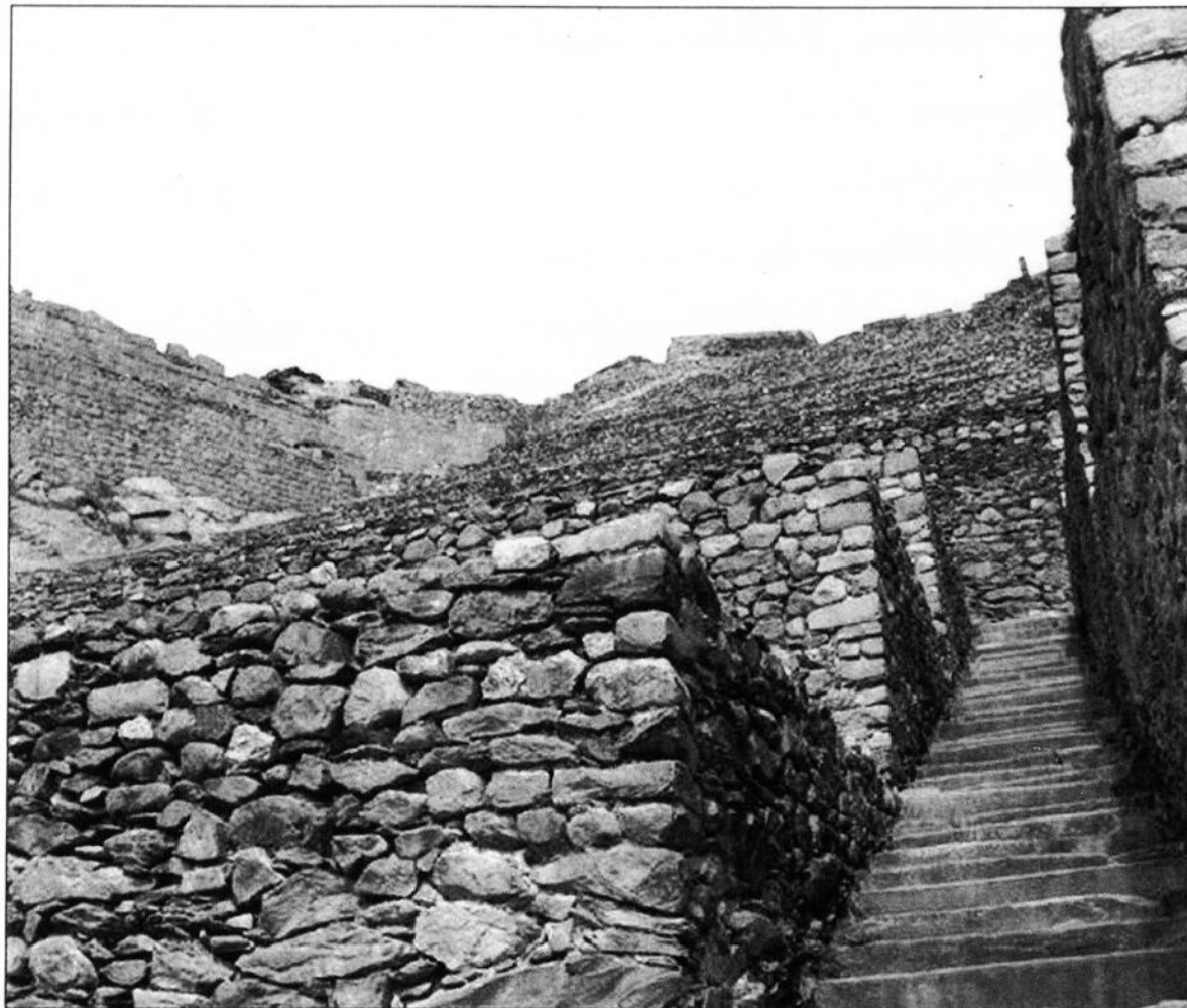
Tout comme à Machu Pichu, les pierres sont retenues par de la terre.
