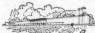
PONT-VAIU 1055, boul. des Laurentides
