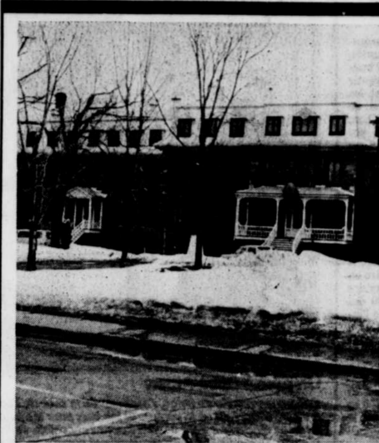
Le Foyer d'Youville, à Montmagny.
