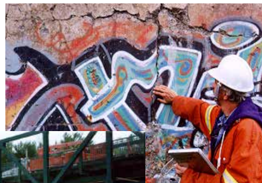
Inspection « le doigt sur la pièce »
