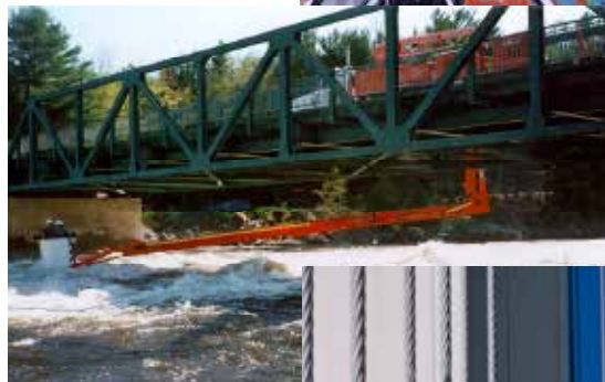
Inspection à l'aide de la nacelle
