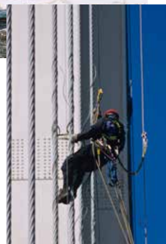
Inspection en appui sur cordes
