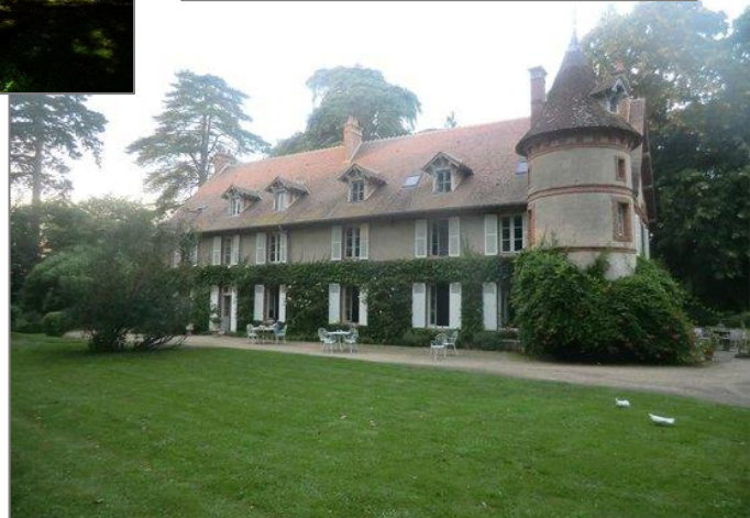
Brinay Ancien lavoir et son château remodelé au XIX e siècle
