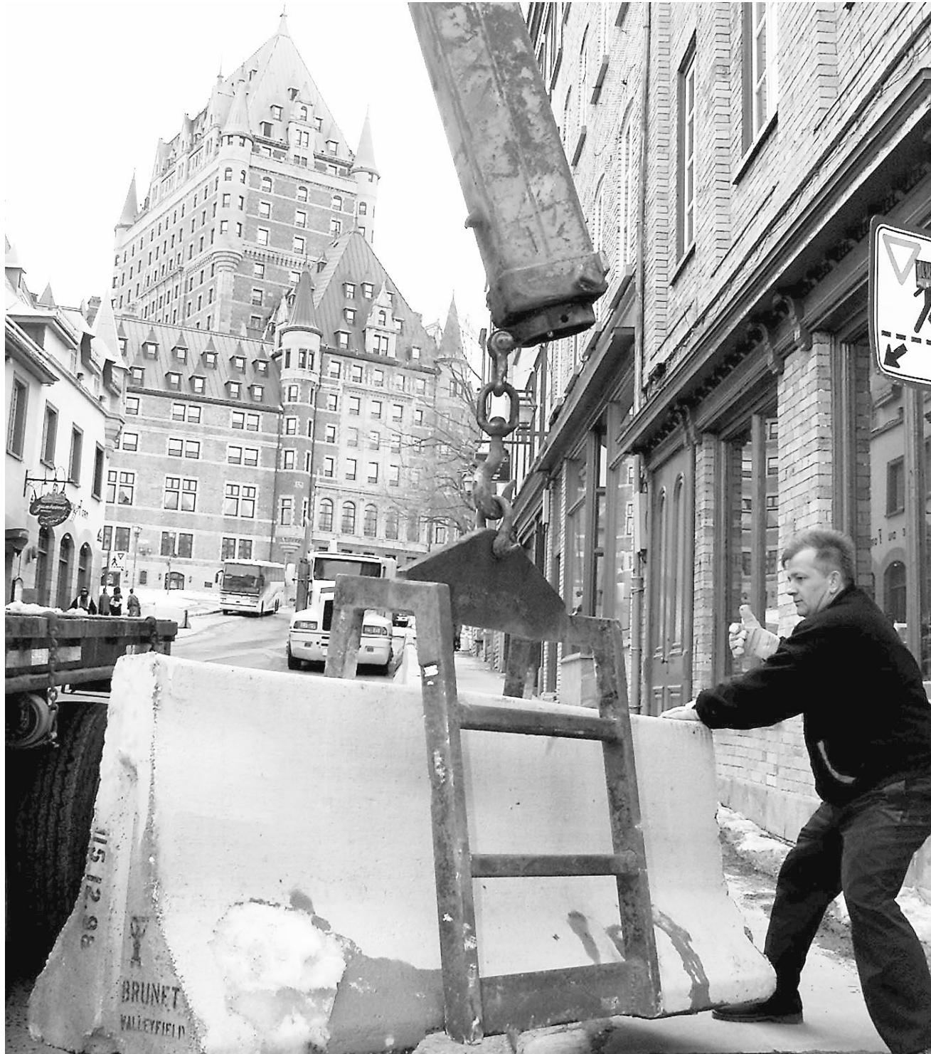
Les travaux entrepris sur la rue Sainte-Anne, dans le Vieux-Québec ont causé quelques désagréments aux automobilistes et aux promeneurs, mais rien de majeur.
